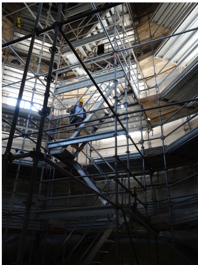
Fig. 3 Ponteggio all'interno della cupola sopra il piano del tamburo.
