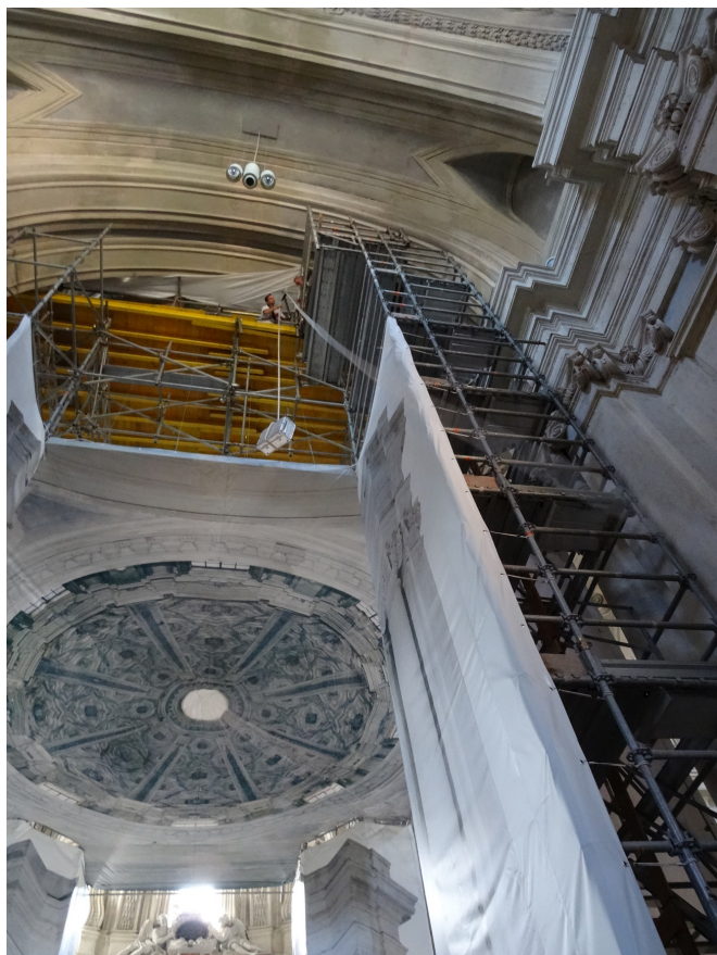
Fig. 2 Un momento del trasporto della strumentazione tramite paranco fino al piano del tamburo
