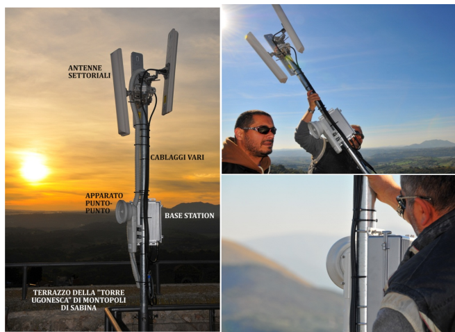
Foto 3a,b,c. Fasi dell'installazione delle antenne sul terrazzo della Torre.
