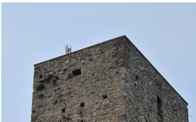
Foto 4. Impianto ultimato. Vista da terra.
