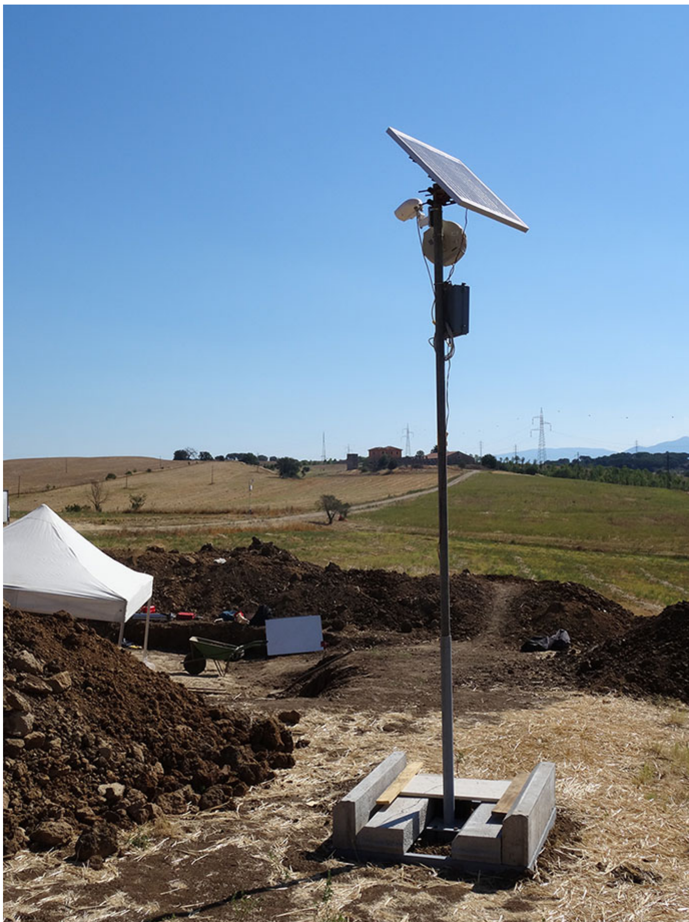
Fig. 15 Stazione autoalimentata presso Crustumerium.
