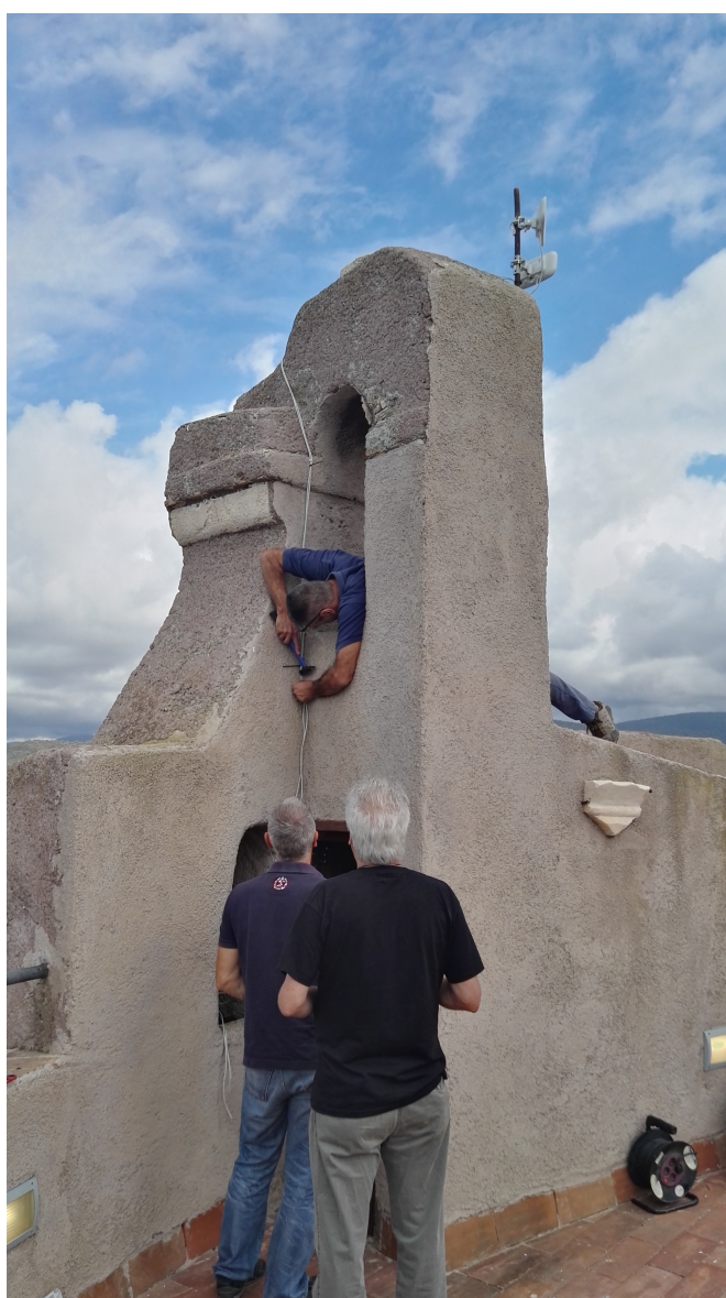
Fig. 7 Montaggio delle antenne sulla torre del Castello di S. Severa.
