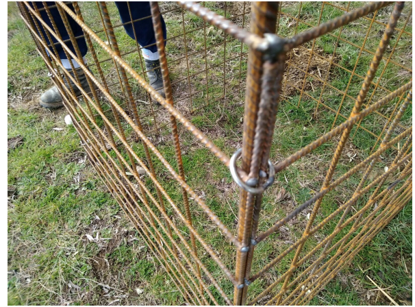
Fig. 17 Particolare della gabbia assemblata
