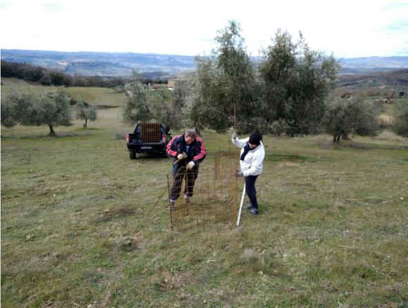
**Fig. 15** Operazioni di montaggio in campo: inserimento dei paletti di ancoraggio e bloccaggio mediante inserimento nel suolo dei paletti
