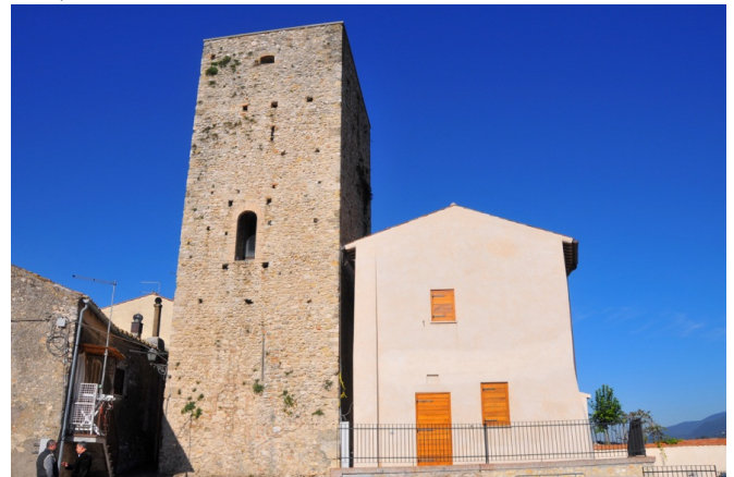
Foto 1. Torre Ugonesca di Montopoli di Sabina prima dell'installazione dell'impianto.
